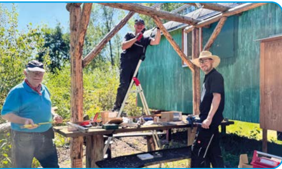
v. l. n. r.: Eberhard Zentgraf, Udo Sauer und Anton Wolff bei der Montage der PV-Anlage
