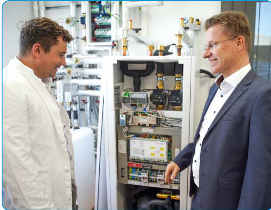
Prof. Dr.-Ing. Klaus Zindler (rechts) mit Manuel Gorks (wissenschaftlicher Mitarbeiter) im NETZ-Labor für Wärmepumpensysteme und innovative Speichertechnologien
